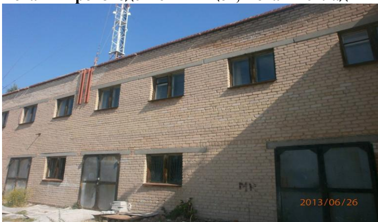
Корпус № 3 – производственное помещение (незавершенное строительство)
