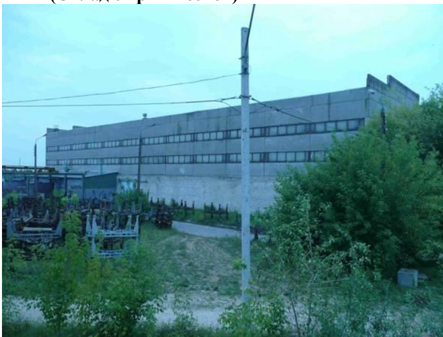
ФОТО объекта (Склад сырых песков)
