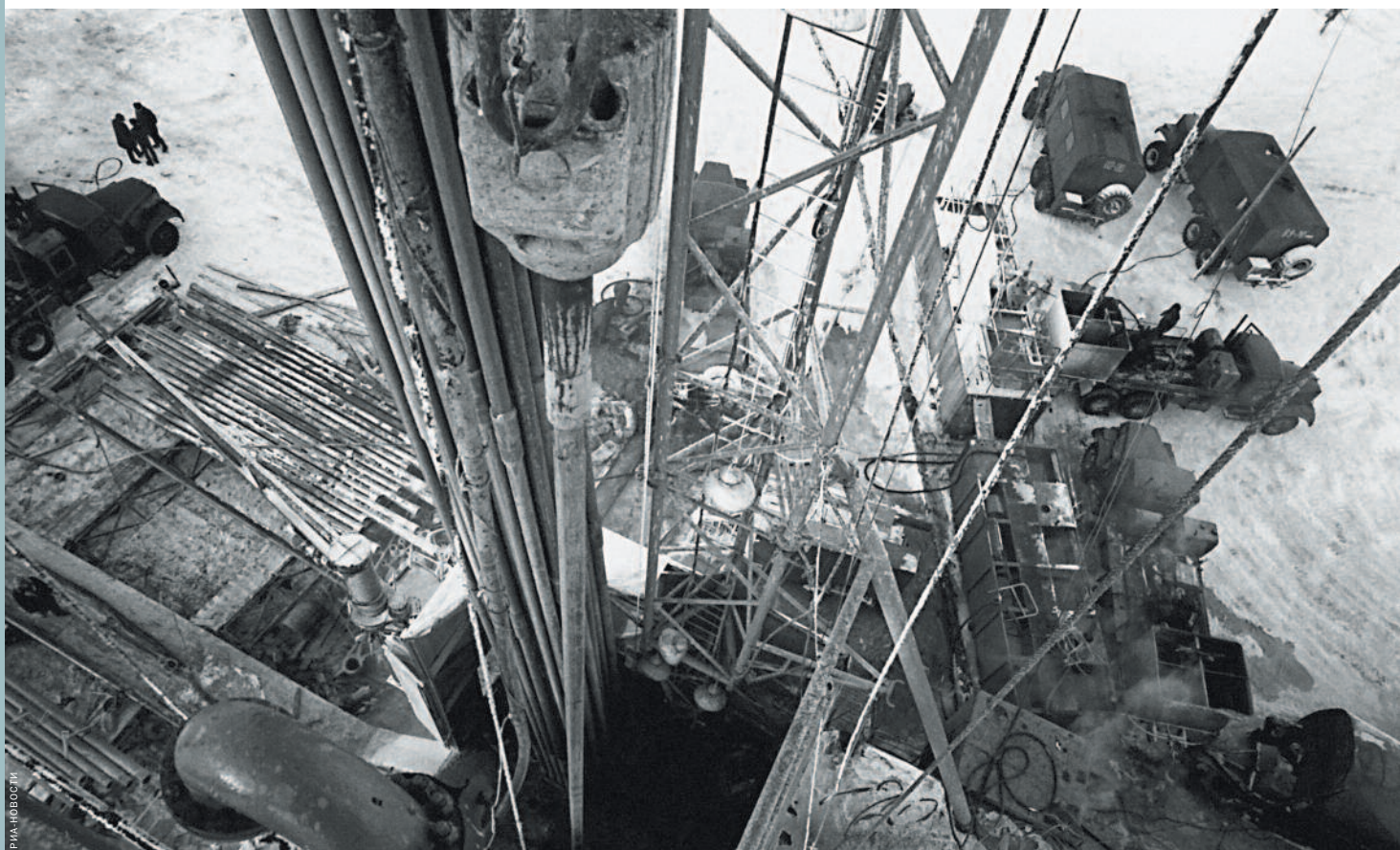
Строительство газопровода стало крупнейшим проектом 1970–1980-х гг.
